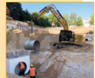
Kanalneubau und setzen eines Schachtes
