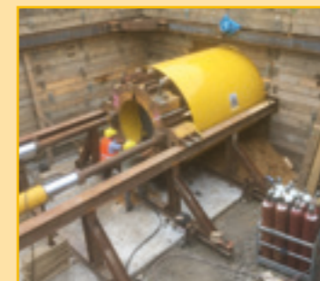
Rohrvortrieb im Zuge einer Erschließung
