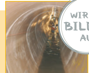
Fertig saniertes Eiprofil in Indien
