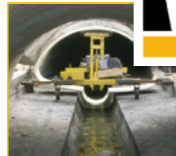
Einbringen eines Rohrs mit dem Rohreinzugswagen
