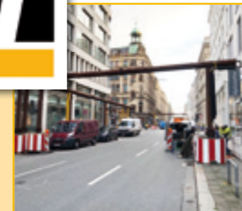
Wasserhaltung mit aufgeständerter Rohrbrücke
